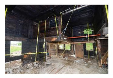
Gurten helfen, das Ganze Bauwerk zu stabilisieren.
